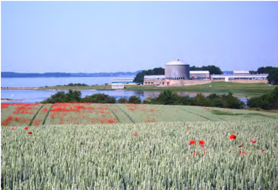
Dansk Reaktor 2 (DR2) set fra hovedvejen langs Roskilde Fjord. Reaktoren er fuldt dekommissioneret.
